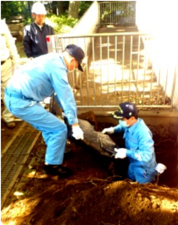
↑区職員による汚染土の埋め戻し作業
