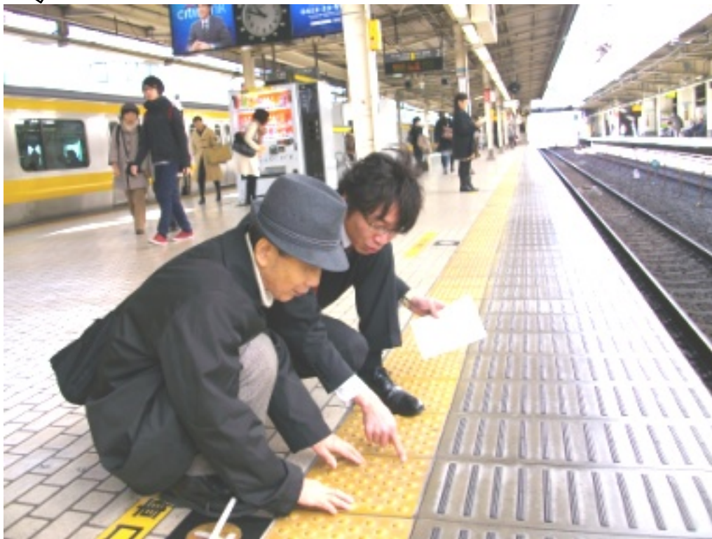
↑ JR駅のホームで警告用の点字ブロックを確認。点が多すぎるブロックは逆に判別しにくいそうです。
