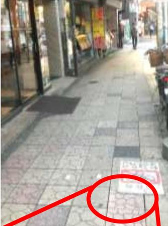
11月初旬に方南通りの歩道のタイルが大きく陥没しているのを発見。周りのタイルとの段差が3～4cmほどで、転倒事故の危険が。
