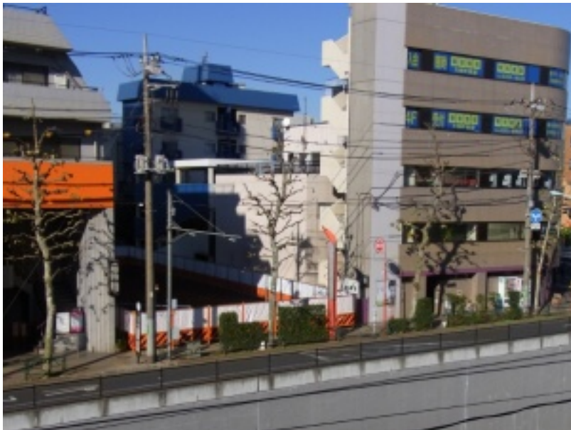
↑更地となっているエレベータ設置用地。
