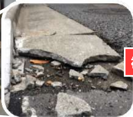
↑ぼろぼろに砕けたL字溝のブロック。
