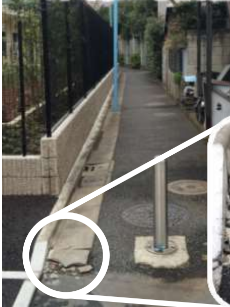
↑ぼろぼろに砕けたL字溝のブロック。
