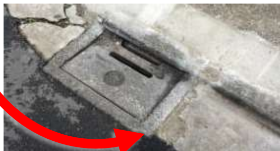
↑改修で段差が無くなった排水溝。
