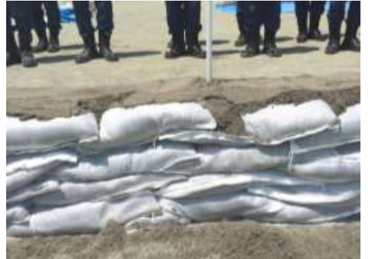
↑土嚢を均等に積み上げて水を止める。
